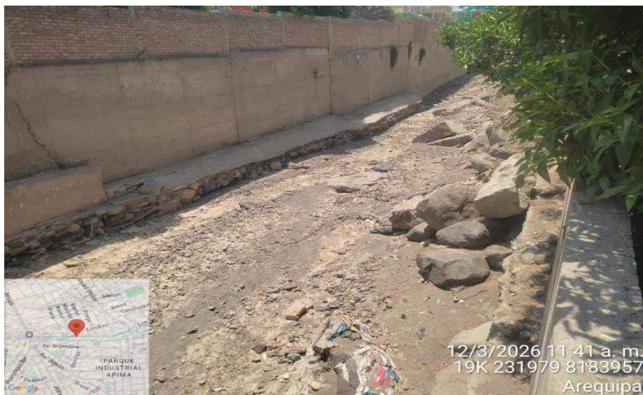
IMAGEN 01: SE OBSERVA LA COLMATACION DEL CAUCE DE LA QUEBRADA LOS INCAS EL SECTOR MARIA NIEVES, REQUIERE DE DEMOLICION Y DE LA CONSTRUCCION DE MURO DE CONTENCION.
