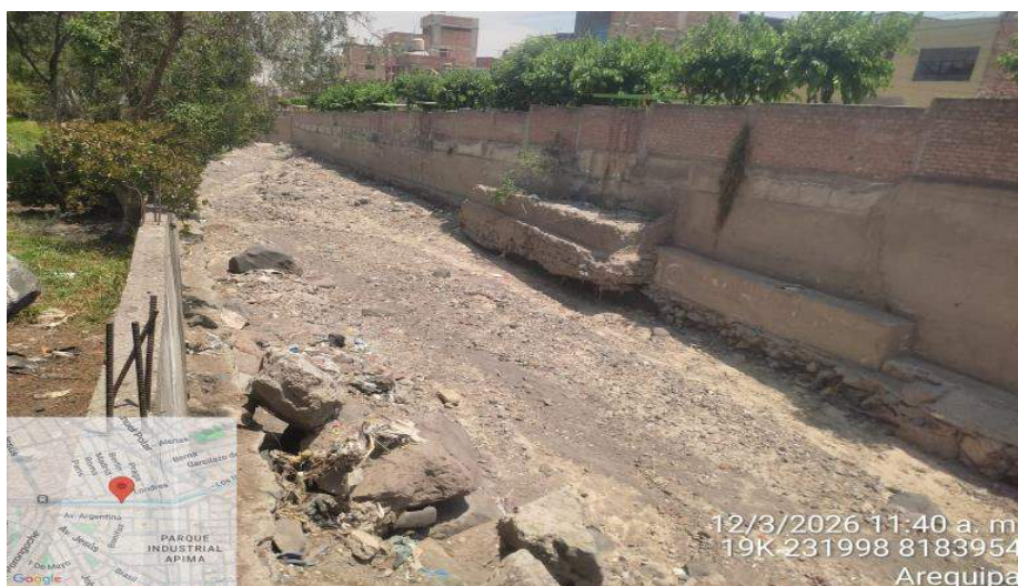
IMAGEN 02: SE OBSERVA LA MARGEN DERECHA QUE REQUIERE DE DESCOLMATACION SE TIENE LA BASE DEL MURO EROSIONADO PARA DEMOLICION Y CONTRUCCION DE MURO Y EVITAR LA POSIBLE AFECTACION A VIVIENDAS,
